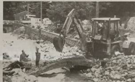
Si lavora per rimuovere i detriti accumulati dalla furia delle acque (foto Borghesi)
